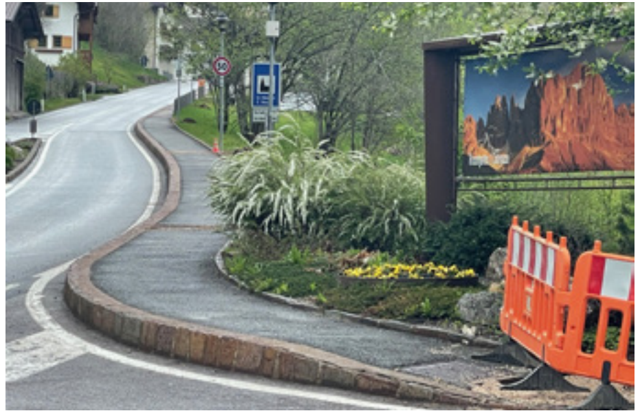
Die Bauarbeiten für die Umstellung der öffentlichen Beleuchtung auf LED im Bereich Parkplatz Dolomiten bis Welschnofnerhof haben begonnen.
