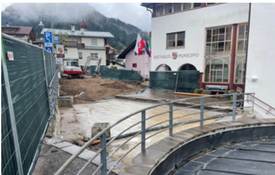
Die Arbeiten zur Sanierung des Platzes vor dem Rathaus haben begonnen und werden ca 2 Monate dauern.
